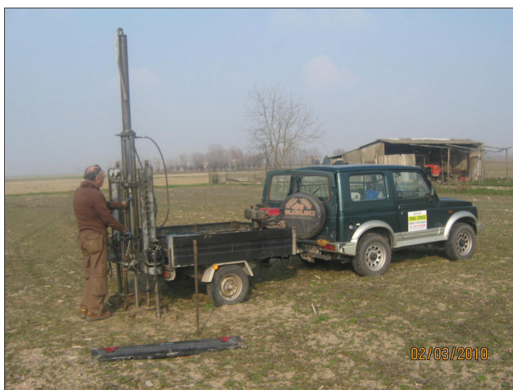
FIGURA 9.1.4 - Fase di esecuzione prova penetrometrica CPT11
