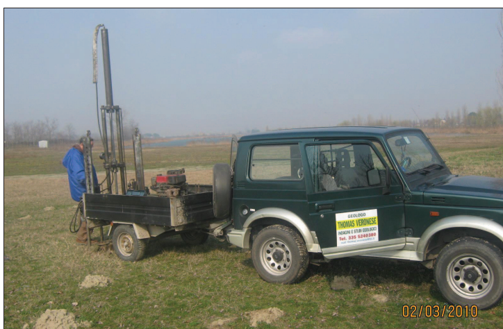
FIGURA 12.1.4 - Fase di esecuzione prova penetrometrica CPT10
