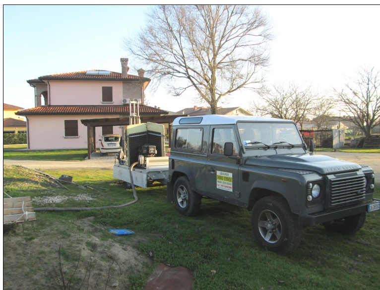
FASE DI ESECUZIONE PROVA PENETROMETRICA STATICA
