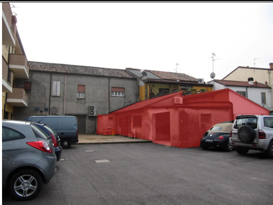
CS5: edifici e manufatti incongrui
